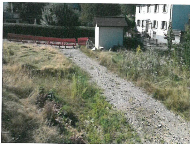
Abbildung 6: Trafohäuschen im südwestlichen Bereich, rechts der Gewässerrandstreifen.
