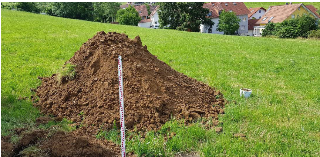
Abb. 5: Schurf SCH5/19, Aushub seitlich gelagert
